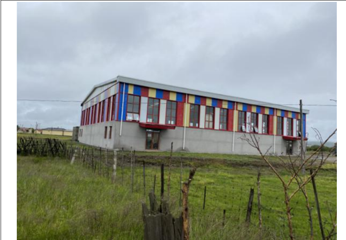
图片 2 江茸乡茸日玛村建设地块现状照片（由于下雨未拍摄航拍图）
